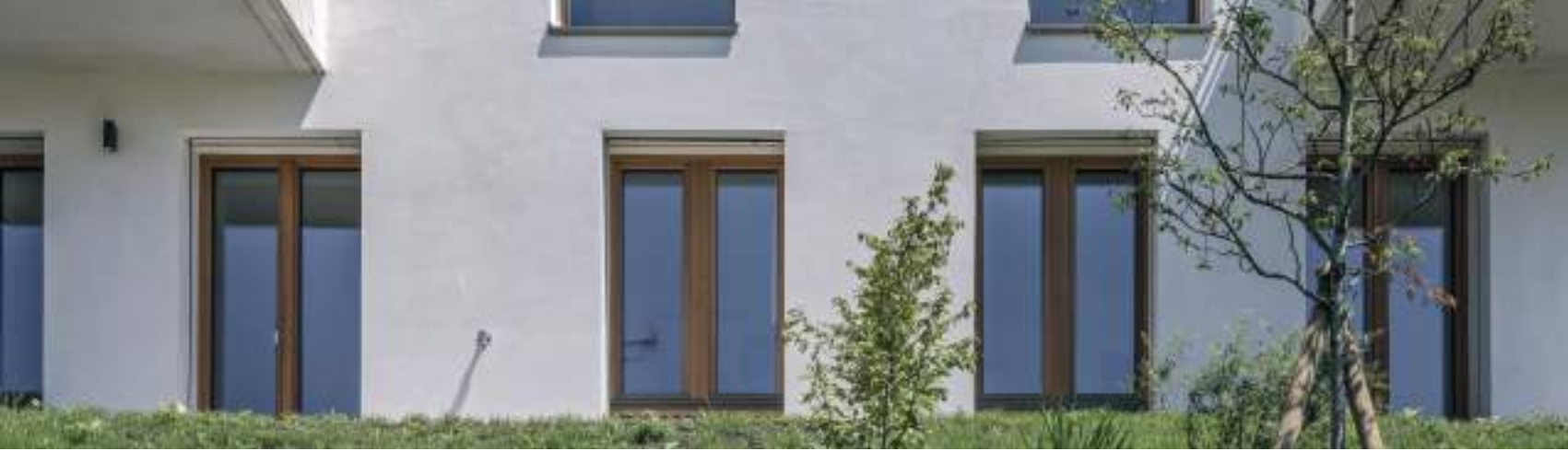
Überragende Energieeffizienz ohne technisches Hochrüsten: die beidseitig mit Kalk verputzten Wände halten als thermische Masse die Raumtemperatur ganzjährig konstant zwischen 22 und 26 Grad - ohne Heizung.
